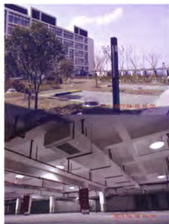
上海电气地下车库
