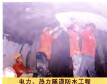
电力、热力隧道防水工程
